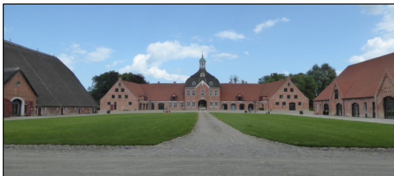
Abb. 15: Gut Hasselburg, Blick auf den Wirtschaftshof mit Torhaus, 1761
