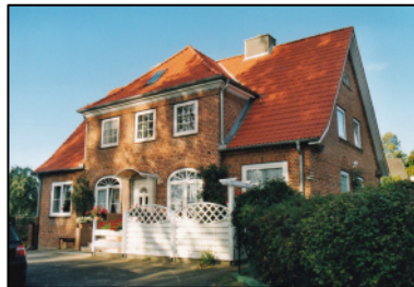
Abb. 23: Zum Wohnhaus umgebautes ehemaliges Kaufhaus Foto von 2003 65
