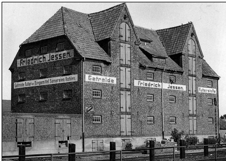
Abb. 44: Getreidespeicher der Firma Friedrich Jessen, Oldenburg, nach 1920 94
