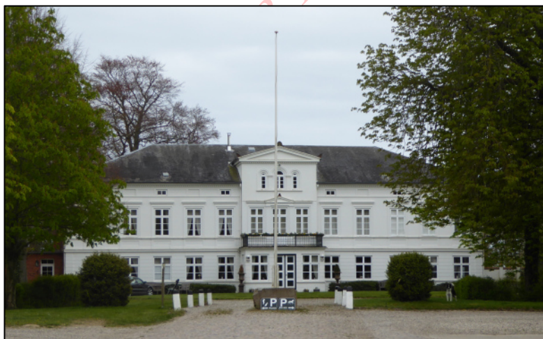
Abb. 27: Herrenhaus auf Rosenhof, aktueller Zustand
