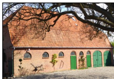
Abb. 41: Scheune Harms Westseite
